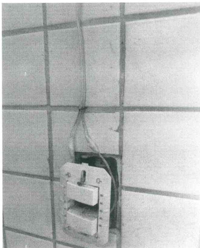
Figura 2: Fiação exposta.
