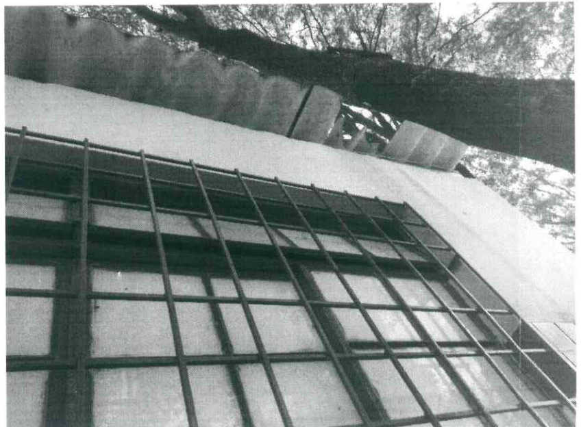
Figura 6: Telhado da sala de projetos.
