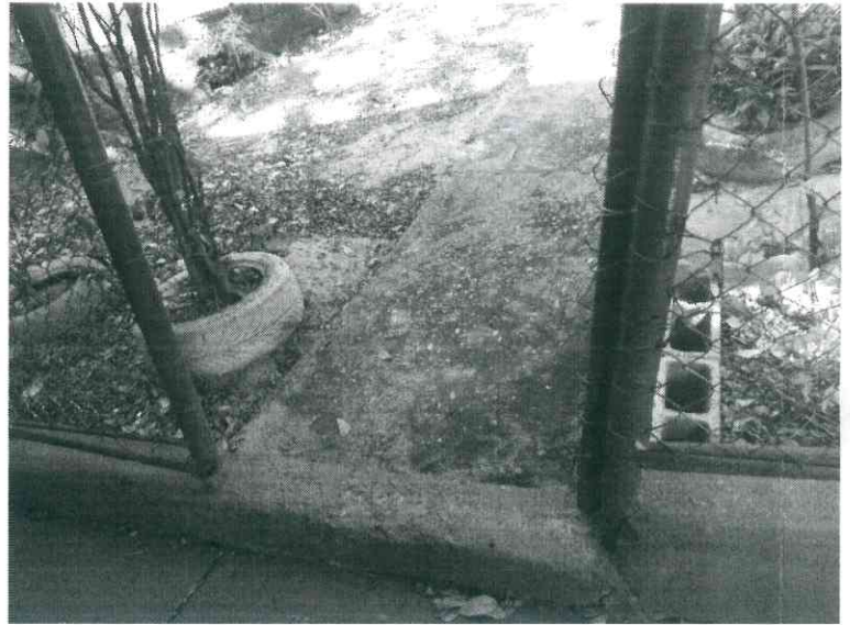
Figura 9: Entrada de acesso para a rampa.
